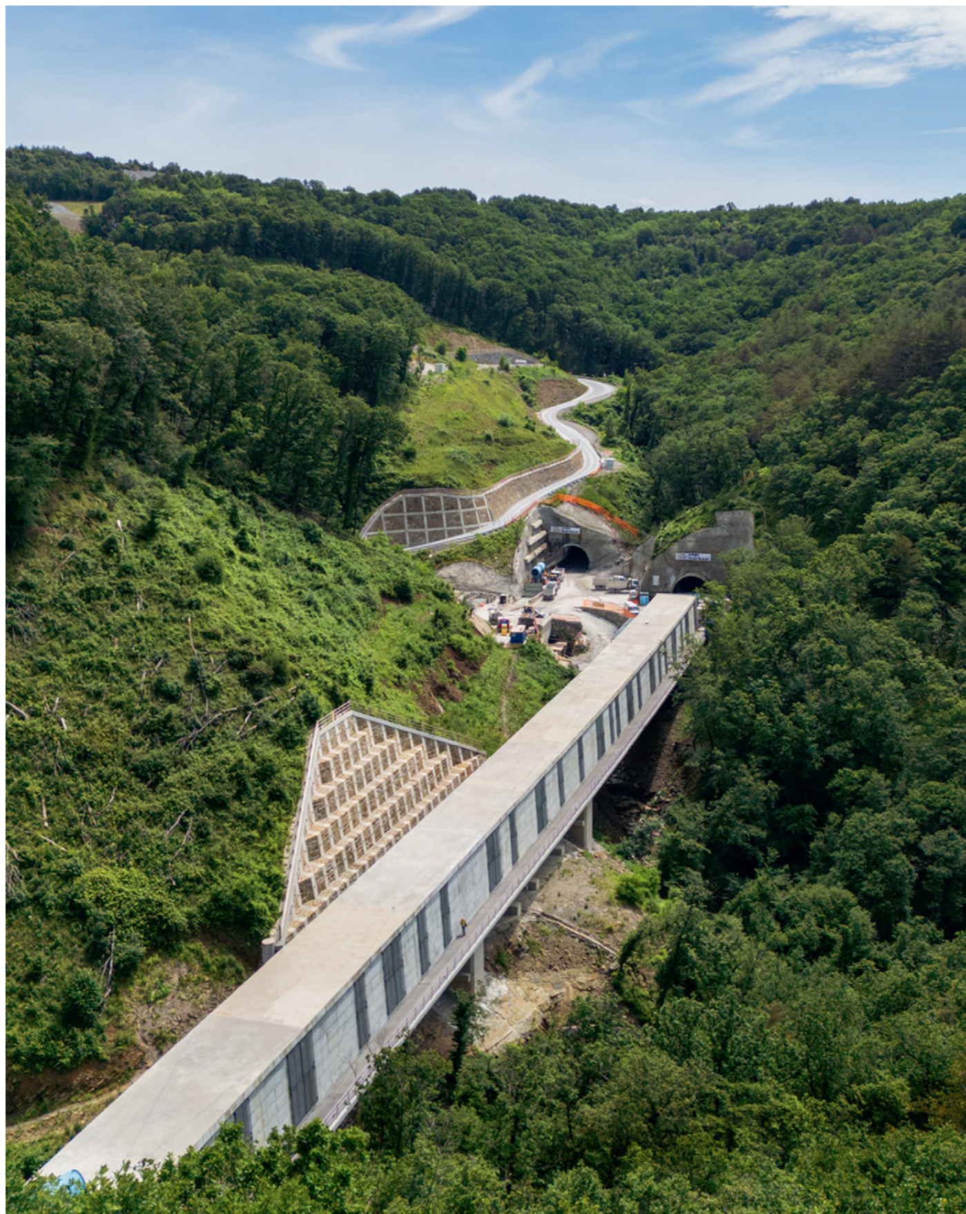
Pri projektu Drugi tir uspešno sodelujemo s podjetji Alpacem Betoni, d.o.o., Kolektor CPG, d.o.o., Euro – Asfalt, d.o.o., in Yapi Merkezi. Fotografija: Miran Kambič.
