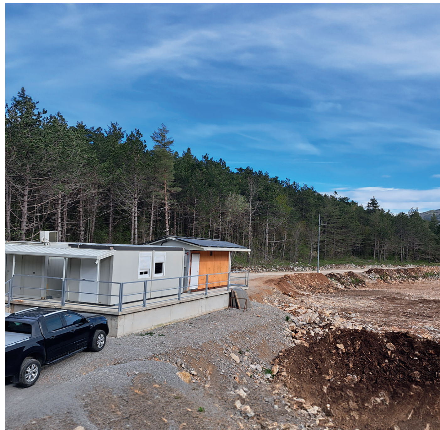
Pisarniški in skladišni kontejnerji v kamnolomu Vrbovo s fotovoltaičnimi paneli na strehi.
