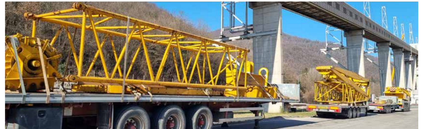
Oprema 400-tonskega avtodvigala za menjavo segmentov transporterja za transport 3D energentov
