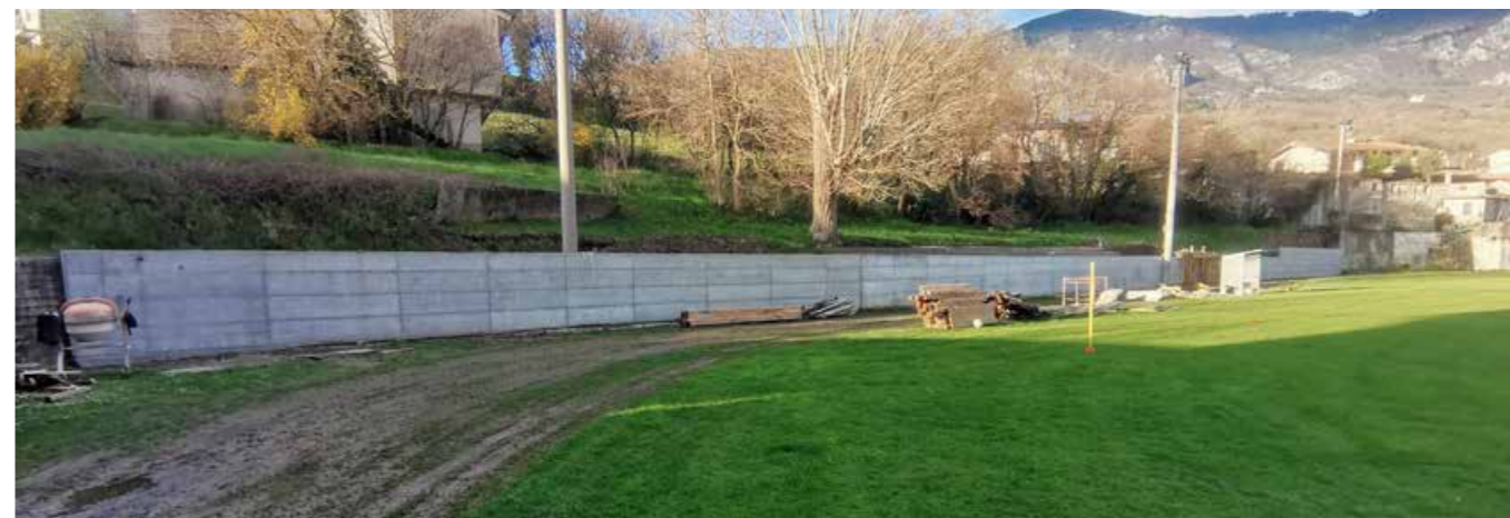
Sanacija poškodovane bržine in dela v teku
