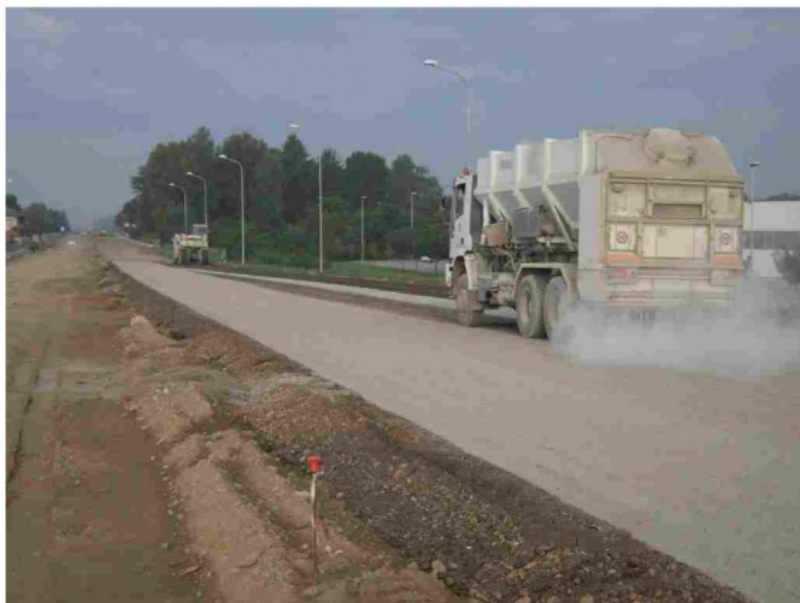
Le caratteristiche tecniche del legante Groundbinder prodotto da w&p Cementi ne hanno consentito l'impiego per la costruzione di importanti opere, come la terza corsia dell'autostrada A4, nel tratto tra Venezia e Trieste.
